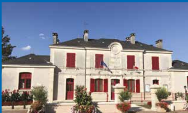
Aménagement des abords et mise en accessibilité de la mairie de Vigoux
