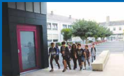
Travaux d'accessibilité handicapé et d'économies d'énergie au collège Les Capucins
