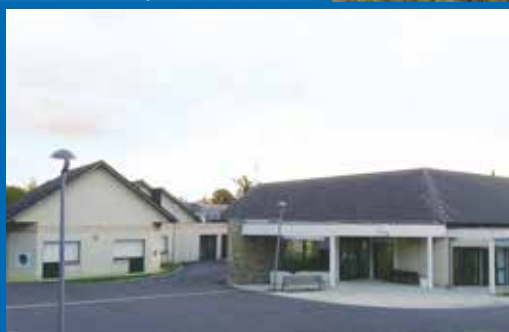
Extension de la maison de retraite d'Aigurande
