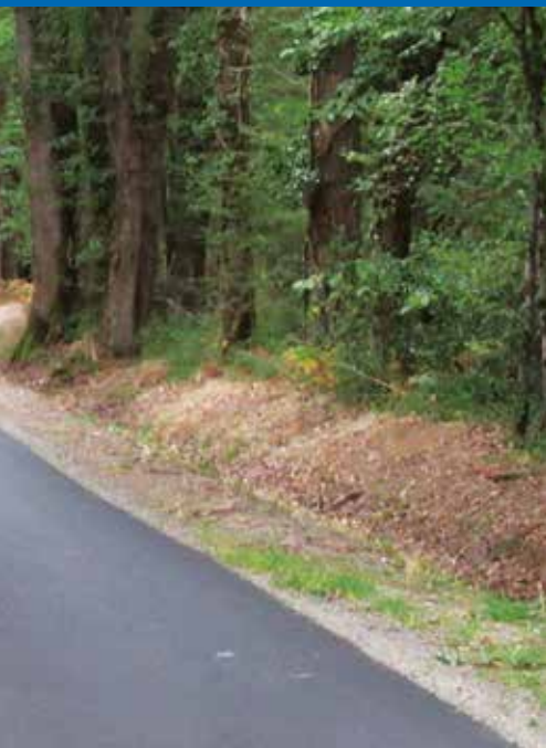
renforcement de la route départementale à Bêlabre
